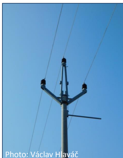
Fig. 19 Console „Pařát“ with a perch
